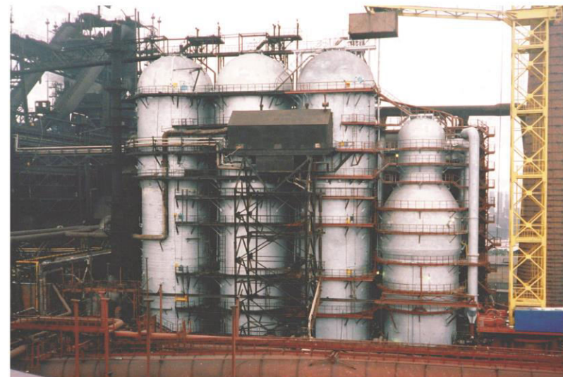
Россия. г. Новокузнецк. ОАО "ЗСМК". ДП №3 объемом 3000 м 3 . Справа - бесшахтный воздухонагреватель Калугина, в эксплуатации с 2002г. Слева - 3 воздухонагревателя с внутренней камерой горения.
