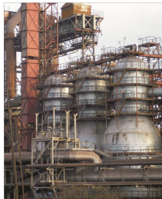
Украина. г. Енакиево. Енакиевский металлургический завод. ДП объемом 1500\text{м}^3 . Блок воздухонагревателей Калугина в эксплуатации с 2007г.
