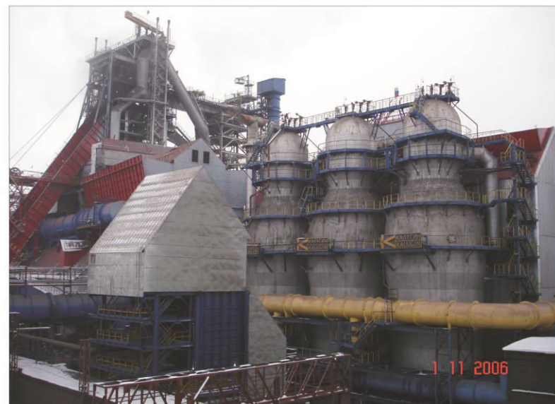
Россия. г. Нижний тагил. ОАО “НТМК”. ДП №5 объемом 2200 м 3 . Блок воздухонагревателей Калугина, в эксплуатации с 2006г.
