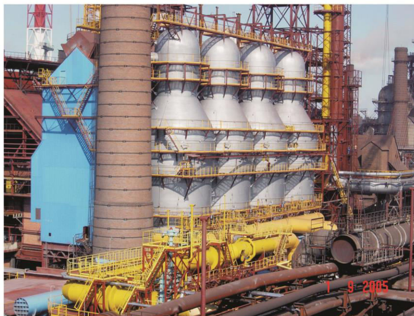
Россия. г. Череповец. ОАО “Северсталь”. ДП №4 объемом 2700 м 3 . Блок воздухонагревателей Калугина, в эксплуатации с 2005г.
