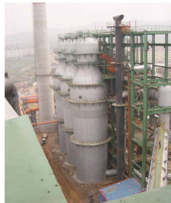
КИТАЙ. Лайуский меткомбинат. ДП объемом 2200\text{м}^3 . Блок воздухонагревателей Калугина, в эксплуатации с июня 2004
