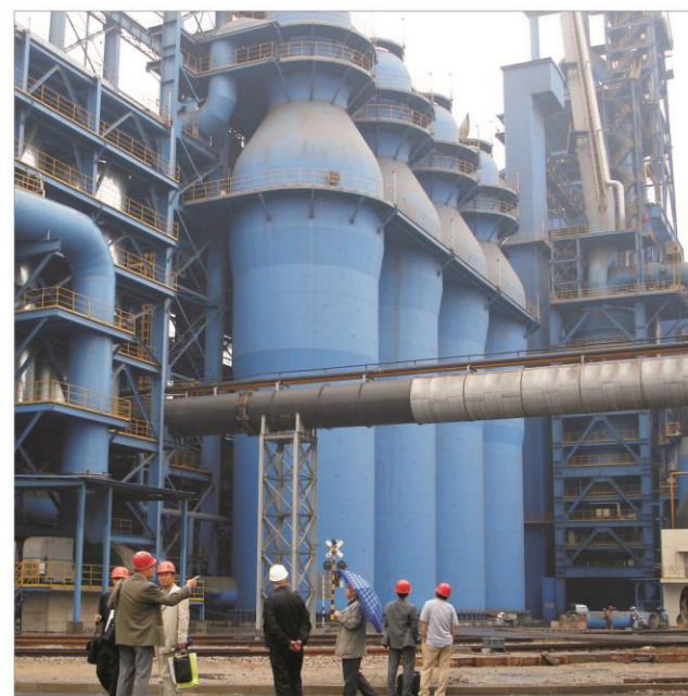
КИТАЙ. Тяньзиньский меткомбинат. ДП объемом 3200 м 3 . Блок воздухонагревателей Калугина, в эксплуатации с мая 2006г.
