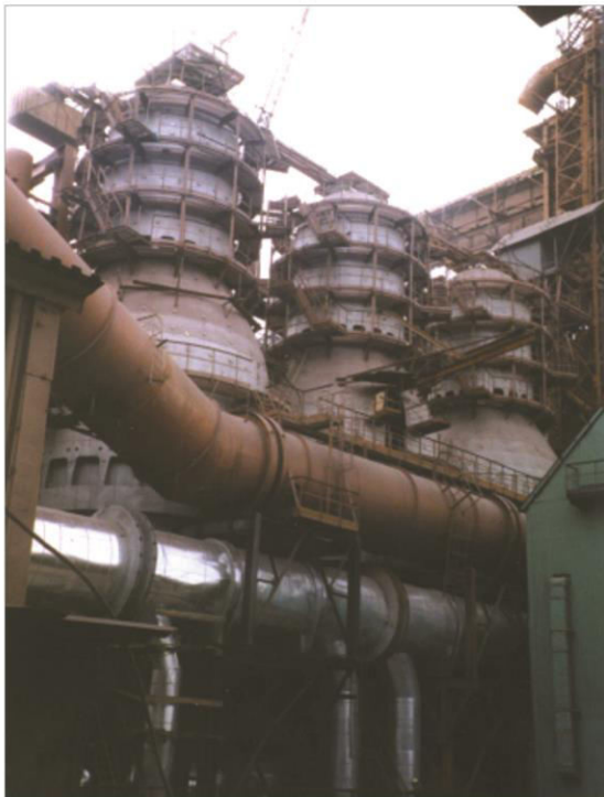
Украина. г. Запорожье. ОАО "Запорожсталь". ДП объемом 1500\text{м}^3 Блок воздухонагревателей Калугина, в эксплуатации с ноября 2004 г. Первый блок бесшахтных воздухонагревателей Калугина на Украине.
