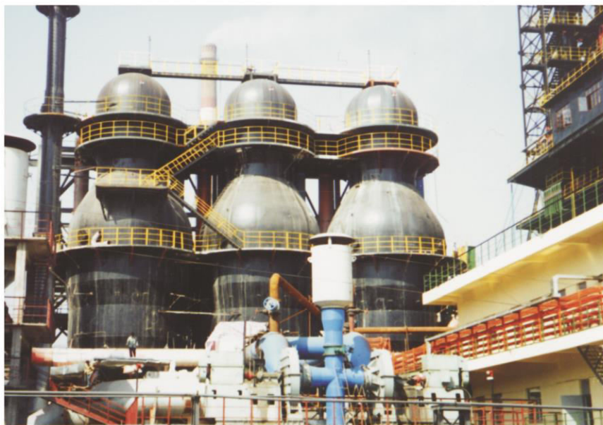
КИТАЙ. Лайуский меткомбинат. ДП объемом 750\text{м}^3 Блок воздухонагревателей Калугина, в эксплуатации с 2002 г. Первый блок бесшахтных воздухонагревателей Калугина в Китае.
