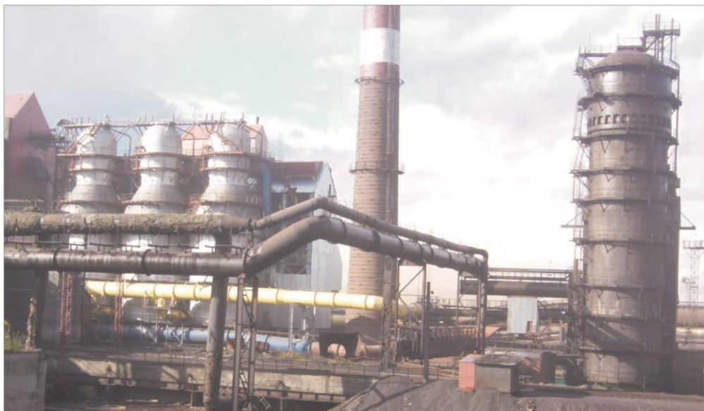
Россия. г. Нижний тагил. ОАО “НТМК”. ДП №6 объемом 2200 м 3 . Справа - один из оставшихся аппаратов старого блока, имевшего 5 воздухонагревателей с внутренней камерой горения. Слева - новый блок из 3 бесшахтных воздухонагревателей Калугина, в эксплуатации с 2004г. Достигнутая температура горячего дутья - 1300 °С.
