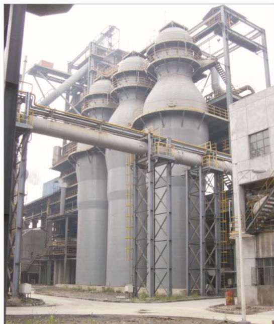
КИТАЙ. Хуайгангский меткомбинат. Две ДП объемом 450 м 3 каждая. Блоки воздухонагревателей Калугина, в эксплуатации с 2004г.
