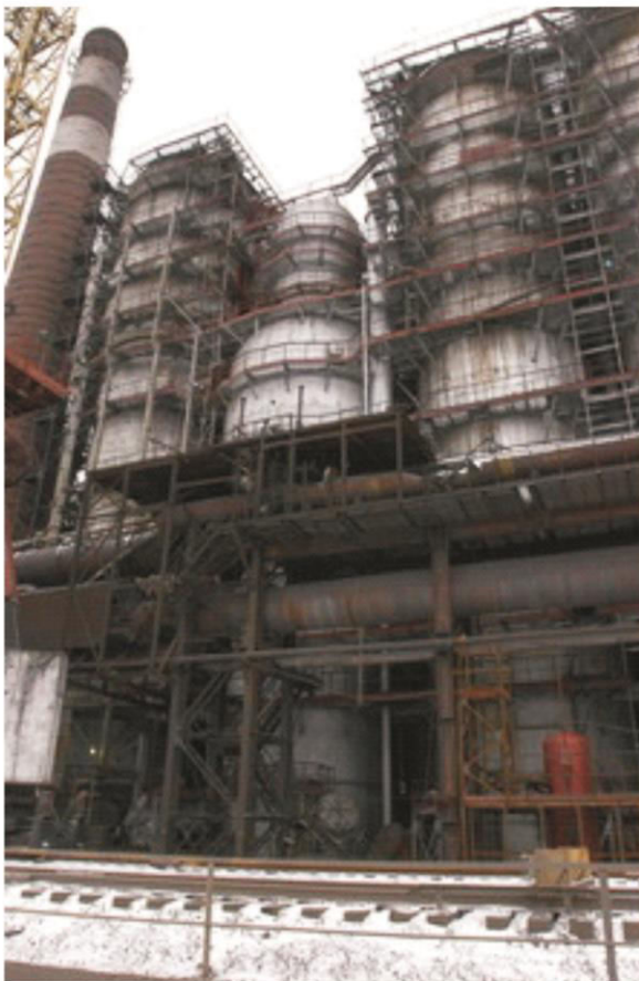
Россия. г. Новокузнецк. ОАО “ЗСМК”. ДП №1 объемом 3000 м 3 . Бесшахтный воздухонагреватель Калугина в центре. В эксплуатации с 2005г. На этой печипостроены еще два воздухонагревателя Калугина
