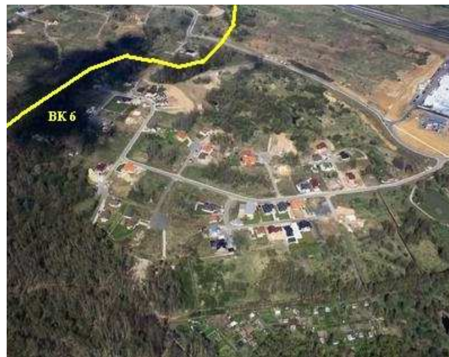
Převáděný biokoridor BK 6 prochází před ekoduktem mezi obytnými komplexy.
