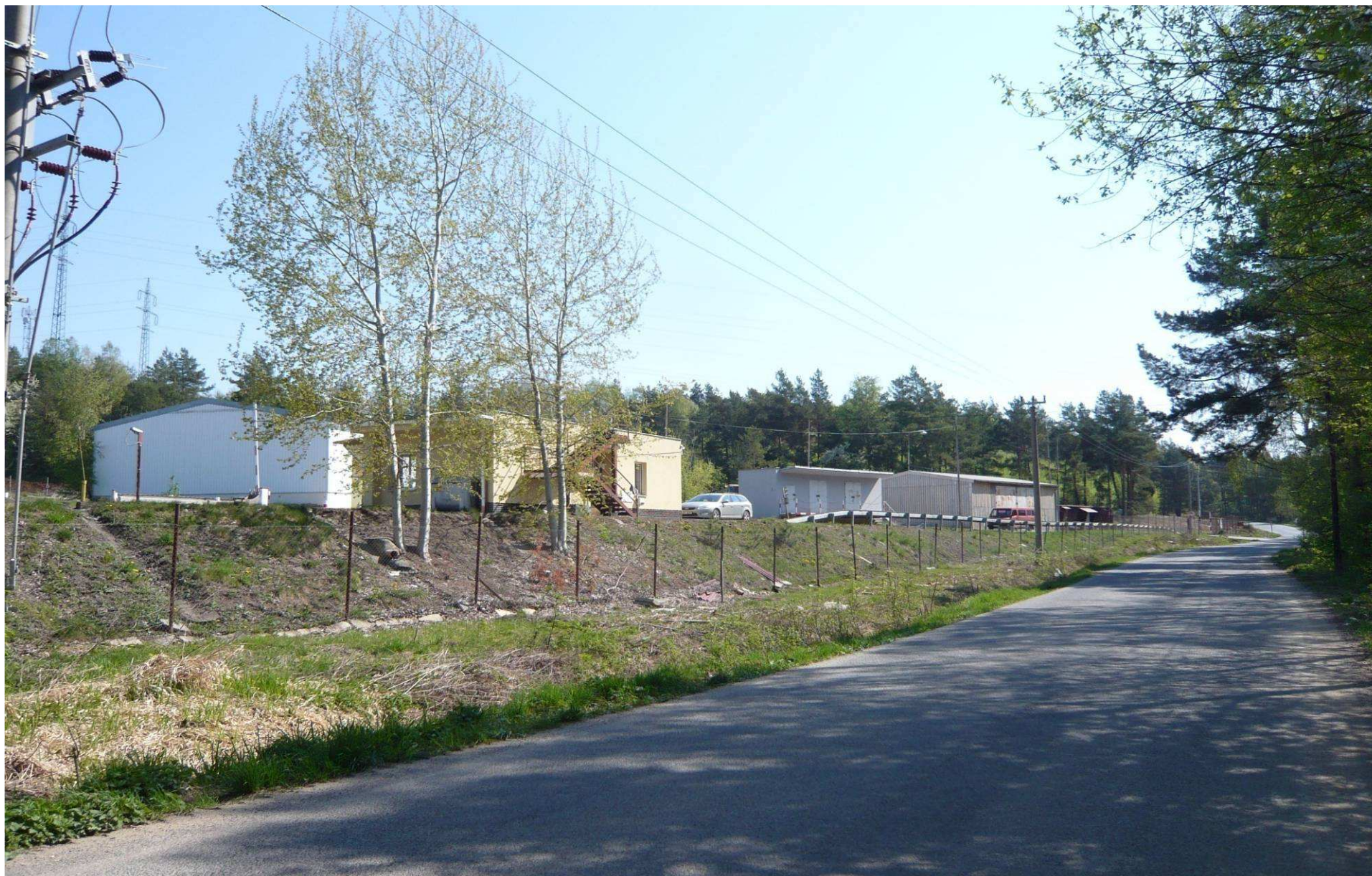
Obr. 7 Pohled na potenciální staveniště ZEVO Chotíkov
