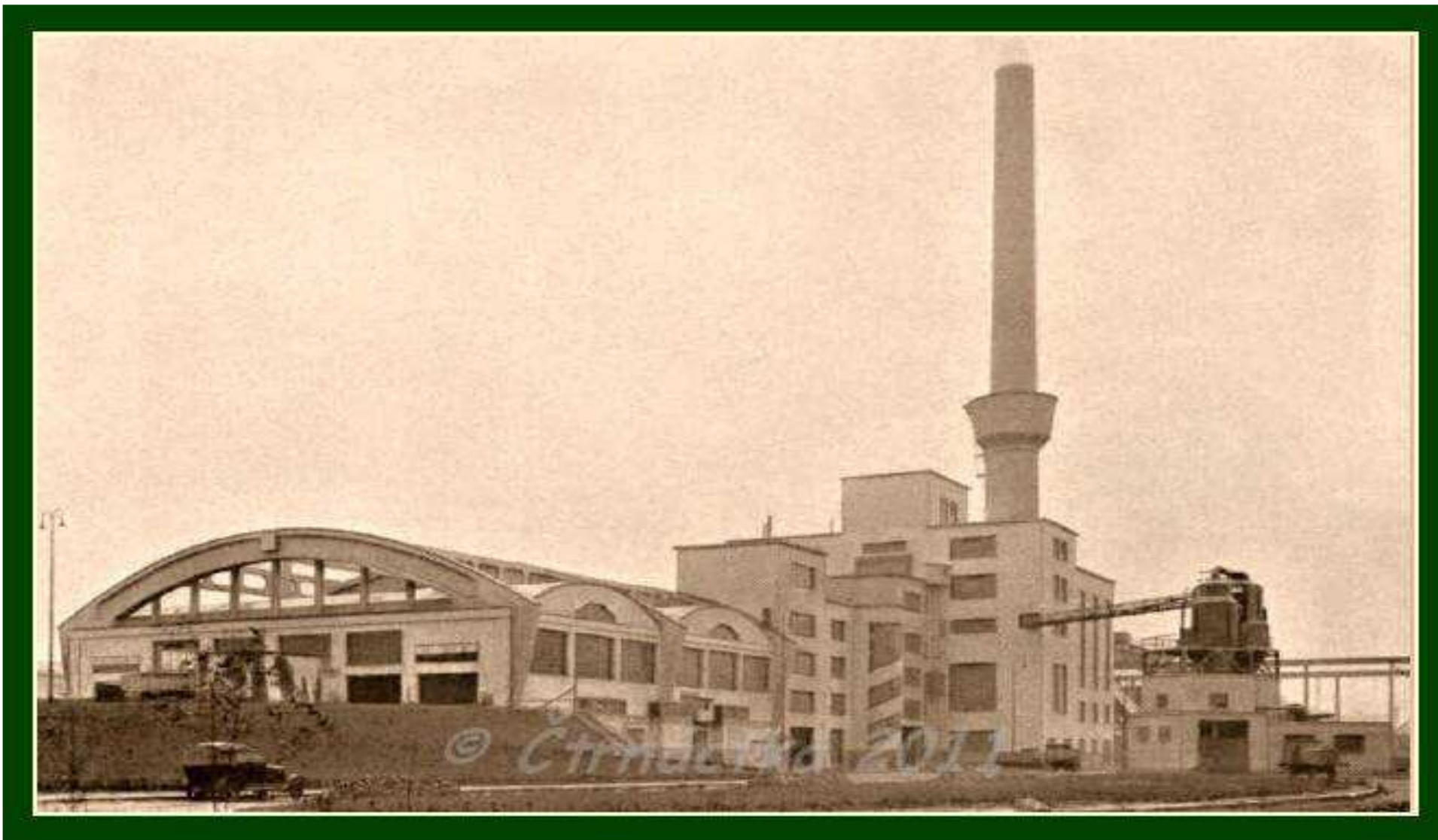
Obr. 2 Spalovna komunálního odpadu v Praze - Vysočanech
