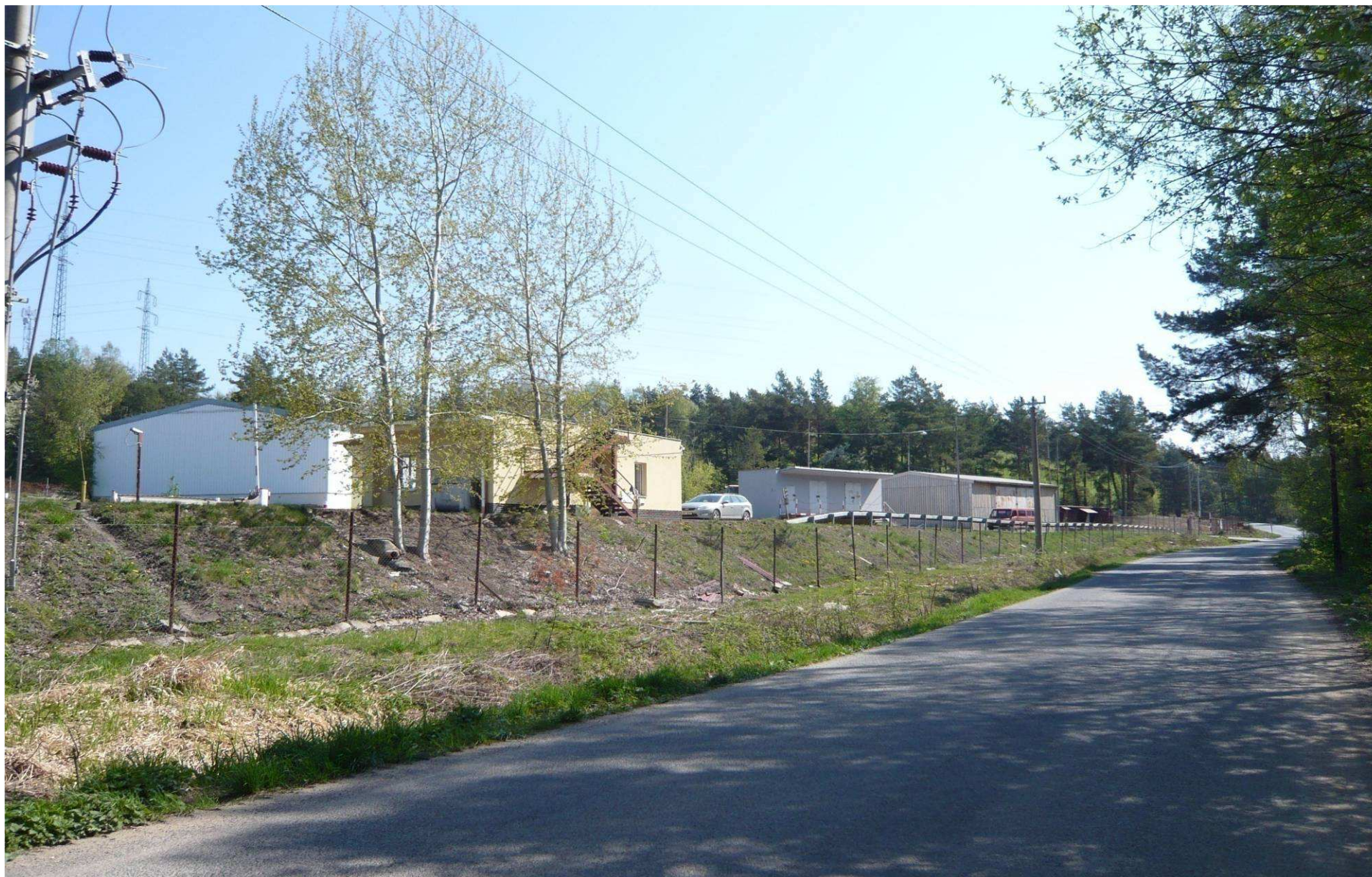
Obr. 7 Pohled na potenciální staveniště ZEVO Chotíkov
