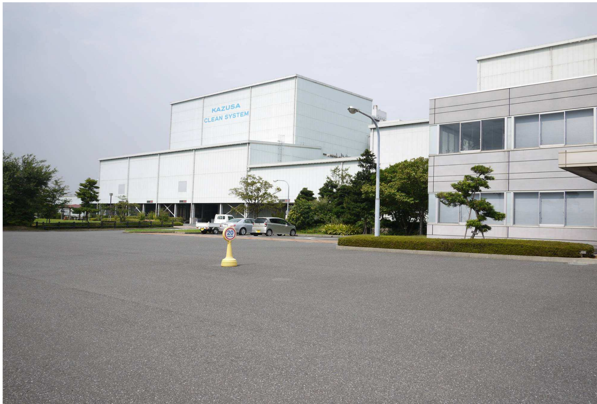
Obr. 4 Kazusa Clean System – objekty spalovny
