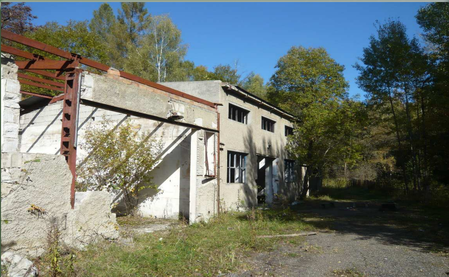
Obrázek 2 Pohled na bývalé zařízení těžebny grafitu Lazec
